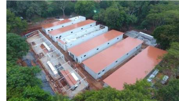
Hôpitaux d'urgence en construction
